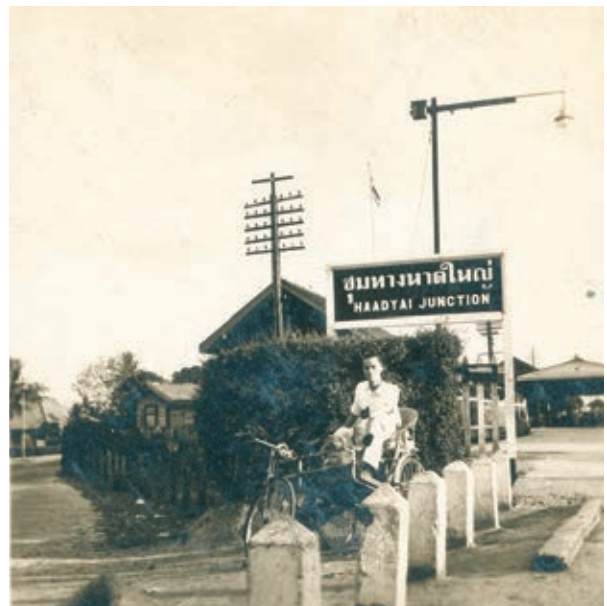
ป้ายสถานีรถไฟชุมทางหาดใหญ่ ก่อนการรื้อเพื่อสร้างอาคารสถานีขนาดใหญ่เมื่อ พ.ศ. ๒๕๐๙ (ภาพจากนายชนินทร์ อินทร์พิทักษ์)
