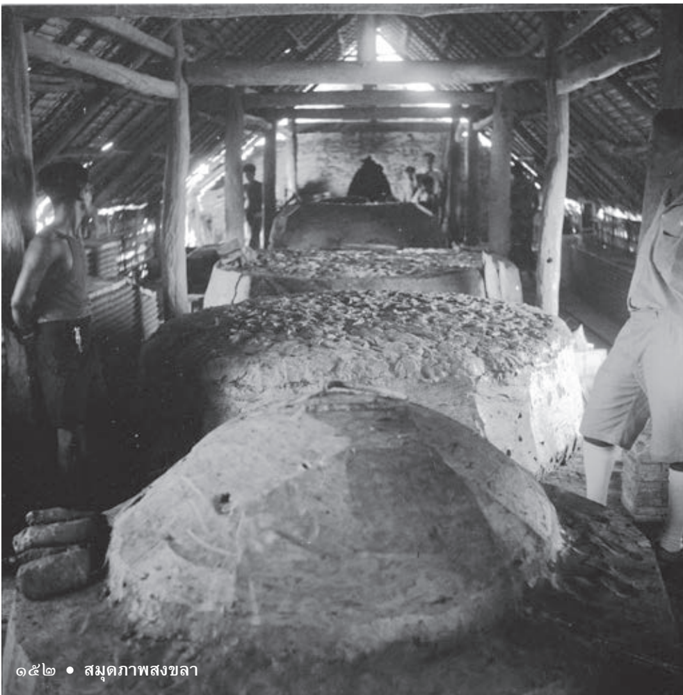
เตาเผากระเบื้องที่เกาะยอ สงขลา มีข้อความกำกับภาพเดิมว่า “เตาเผาที่ปลายสุด มีดินเหนียวสำรอง ๓ กอง ใช้ได้ ๑ ปี เตาเผา ๑๐,๐๐๐ แผ่น ใช้เวลาเผา ๑๙ วัน ทำรอบ ๓ รอบต่อปี มีกระเบื้องแตก ๕ เปอร์เซ็นต์” ถ่ายเมื่อวันที่ ๑๕ ตุลาคม พ.ศ. ๒๔๗๘
