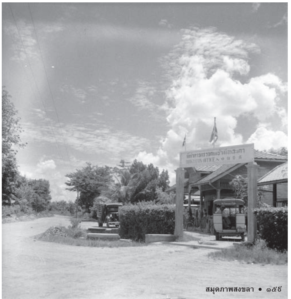
ที่ทำการตรวจคนเข้าเมือง อำเภอสะเตา จังหวัดสงขลา บริเวณแยกทางหลวงในตัว อำเภอสะเตา ทางซ้ายไปด่านนอกสะเตา ทางขวาไปด่านปาดังเบซาร์ ถ่ายเมื่อวันที่ ๔ ตุลาคม พ.ศ. ๒๔๗๙
